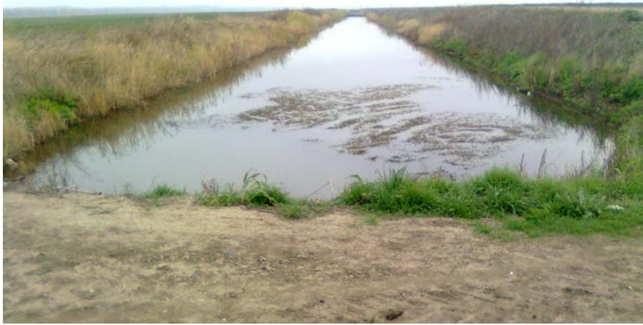
Fig. 36. Subirigație asigurată prin controlul nivelelor freatice în rețeaua de desecare-drenaj din lunca îndiguită.
