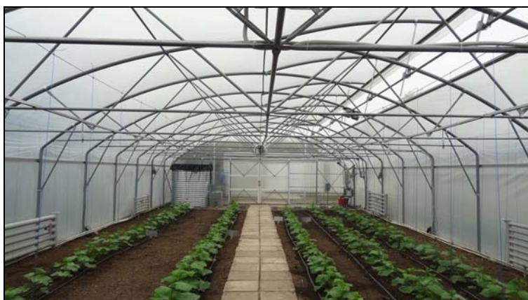
Fig. 66. Instalație pentru irigații și controlul climei în serele legumicole.
